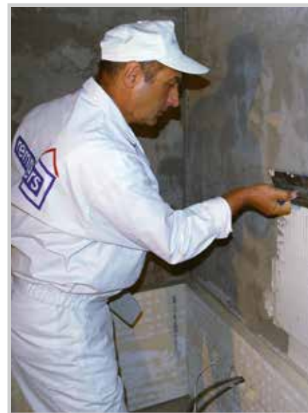
Technik firmy Remmers podczas praktycznego pokazu na budowie
